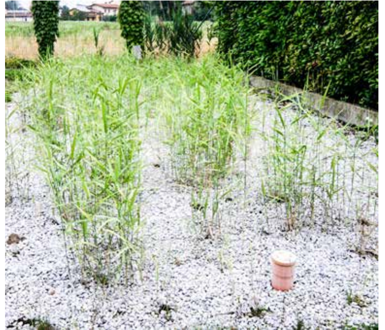
UN IMPIANTO DI FITODEPURAZIONE
