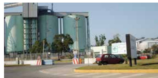
La stabilimento Alcoa di Portovesme
