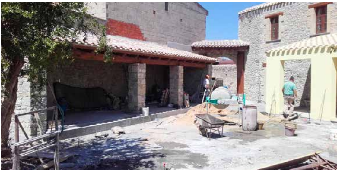
UN CANTIERE DI RISTRUTTURAZIONE
