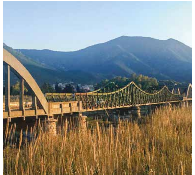
IL PONTE DI FERRO
