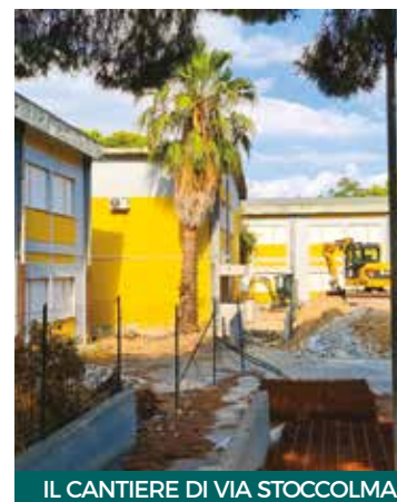
IL CANTIERE DI VIA STOCOLMA
