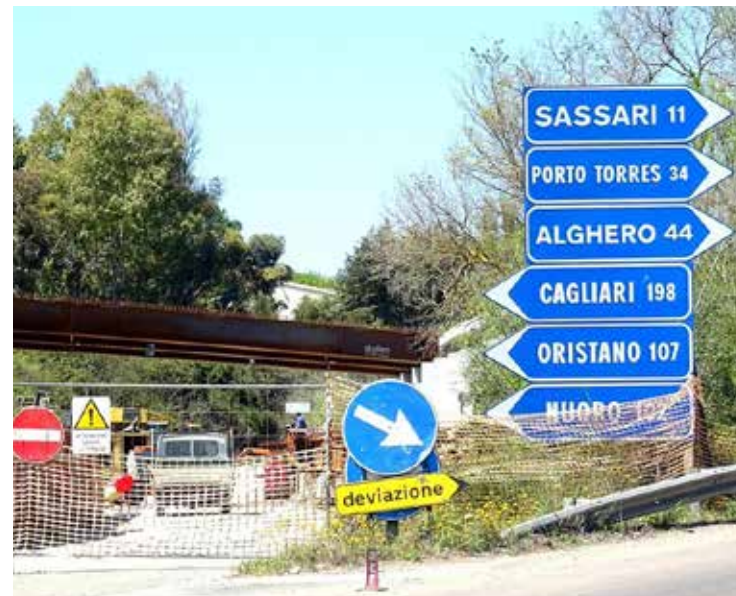
UN CANTIERE STRADALE
