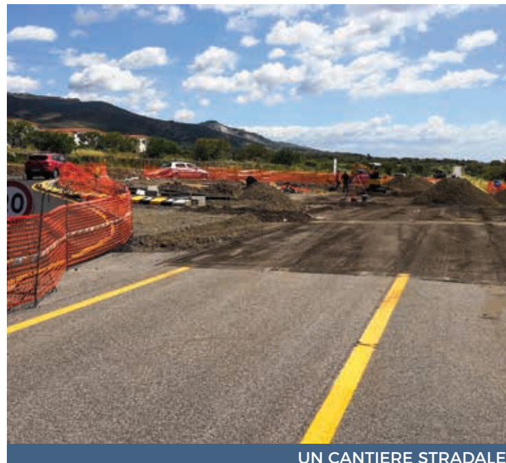
UN CANTIERE STRADALE
