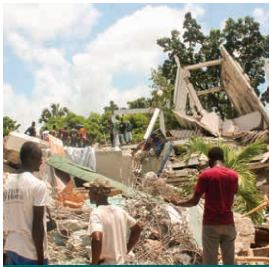
I DANNI DEL TERREMOTO
