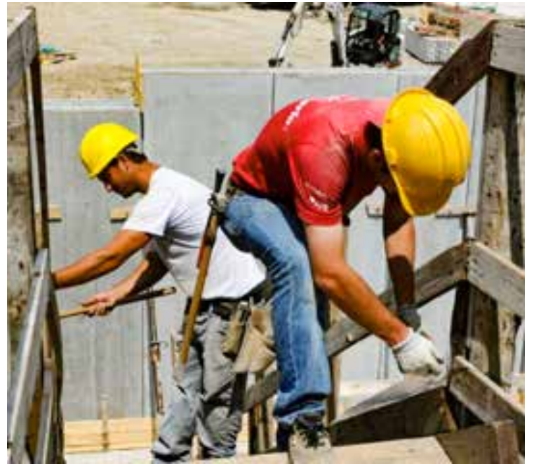
OPERAI IN UN CANTIERE
