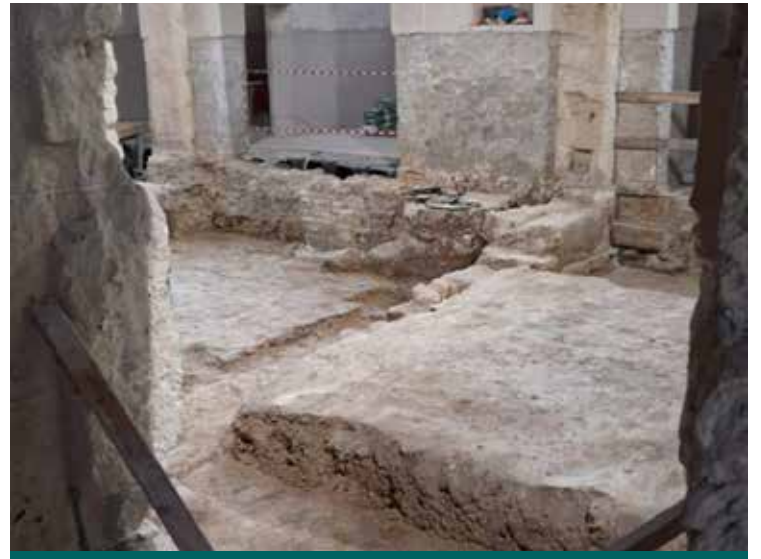
IL CANTIERE A SANT'AVENDRACE
