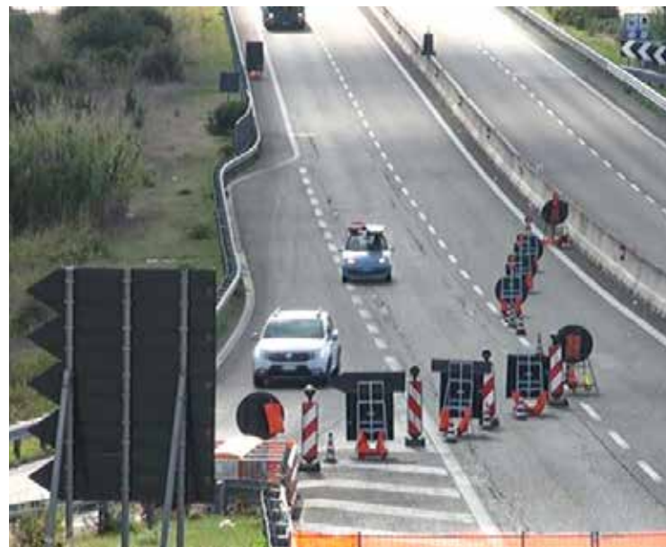
UN CANTIERE STRADALE
