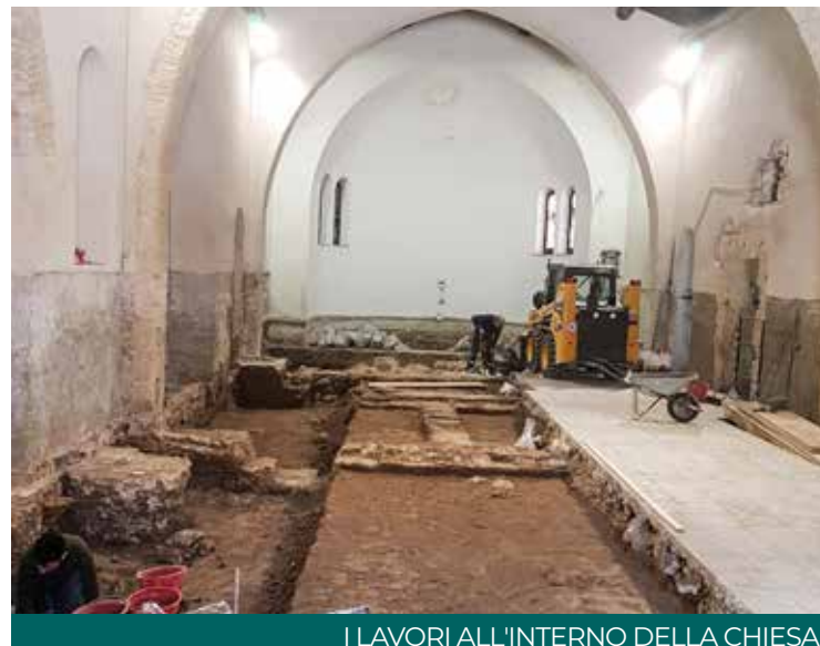
I LAVORI ALL'INTERNO DELLA CHIESA
