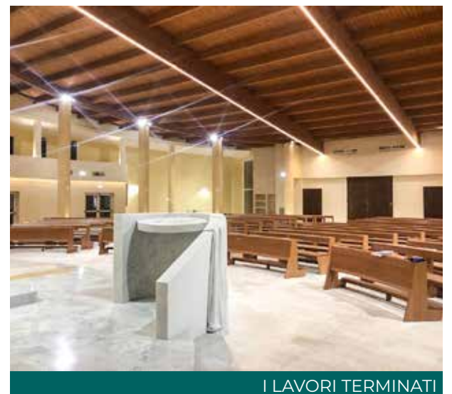
UNO DEI SOPRALLUOGHI
