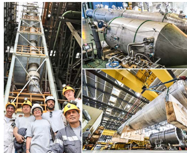
LA VISITA AGLI IMPIANTI
