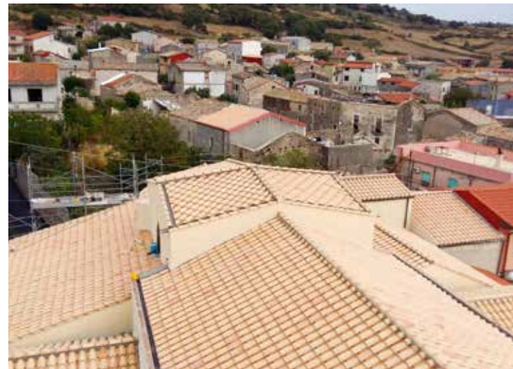
Il tetto della parrocchiale di Orroli dopo i lavori di restauro
